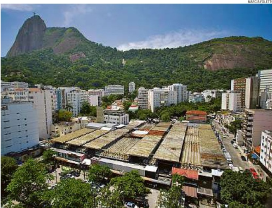
Preservação. O imóvel no Humaitá que foi protegido: somente configuração interna dos boxes poderá ser mudada
