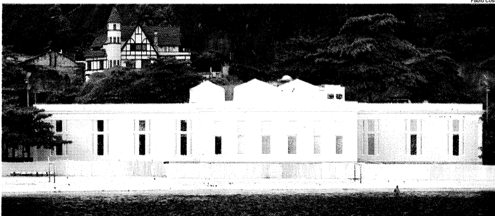
TOMBAMENTO – Depois de reformar um dos prédios por cerca de R$ 8 milhões, o instituto foi impedido de funcionar pela Câmara Municipal
